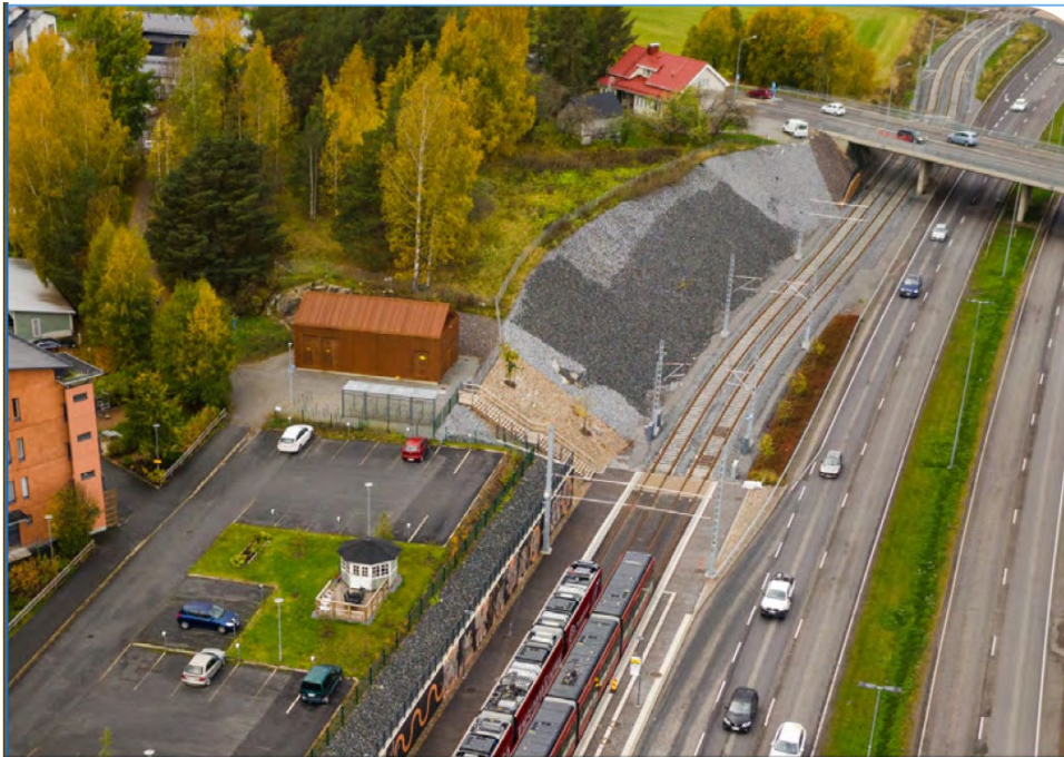
Kuva 5, Sähkösyöttöasema Tampereella, Pasi Tiitola, Tampereen raitiotie Oy
